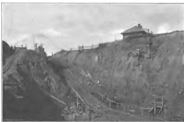
Mine d'Alexandrowsky, entrée et cavité de l'Ouest.
