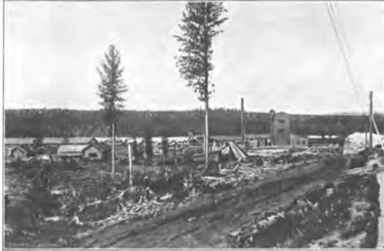
Vue générale des usines de Viols sur la Wichéra.
